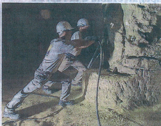
Après avoir injecté la résine, la tige de fibre de verre est insérée par rotation, perçant les poches de résine et scellant ainsi l'ouvrage de consolidation.
