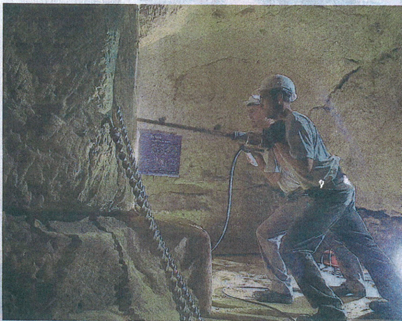
Brézé, roche du château, mercredi matin. Les ouvriers de l'entreprise Pinon forent d'abord le tuffeau par rotation, avant d'injecter la résine qui servira à sceller les tiges de consolidation.
